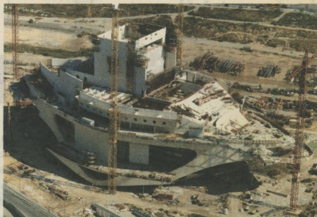
ESTADO DE LAS OBRAS EN SEPTIEMBRE DE ESTE AÑO
