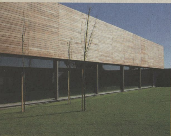
A LA IZQUIERDA, EL COMPLEJO DE LA PISCINA DE LA ARZÚA. ABAJO, DE IZQUIERDA A DERECHA, LAS OFICINAS DE LA CORUÑA Y LA CAFETERÍA EN LA PLAYA DE BALARÉS
