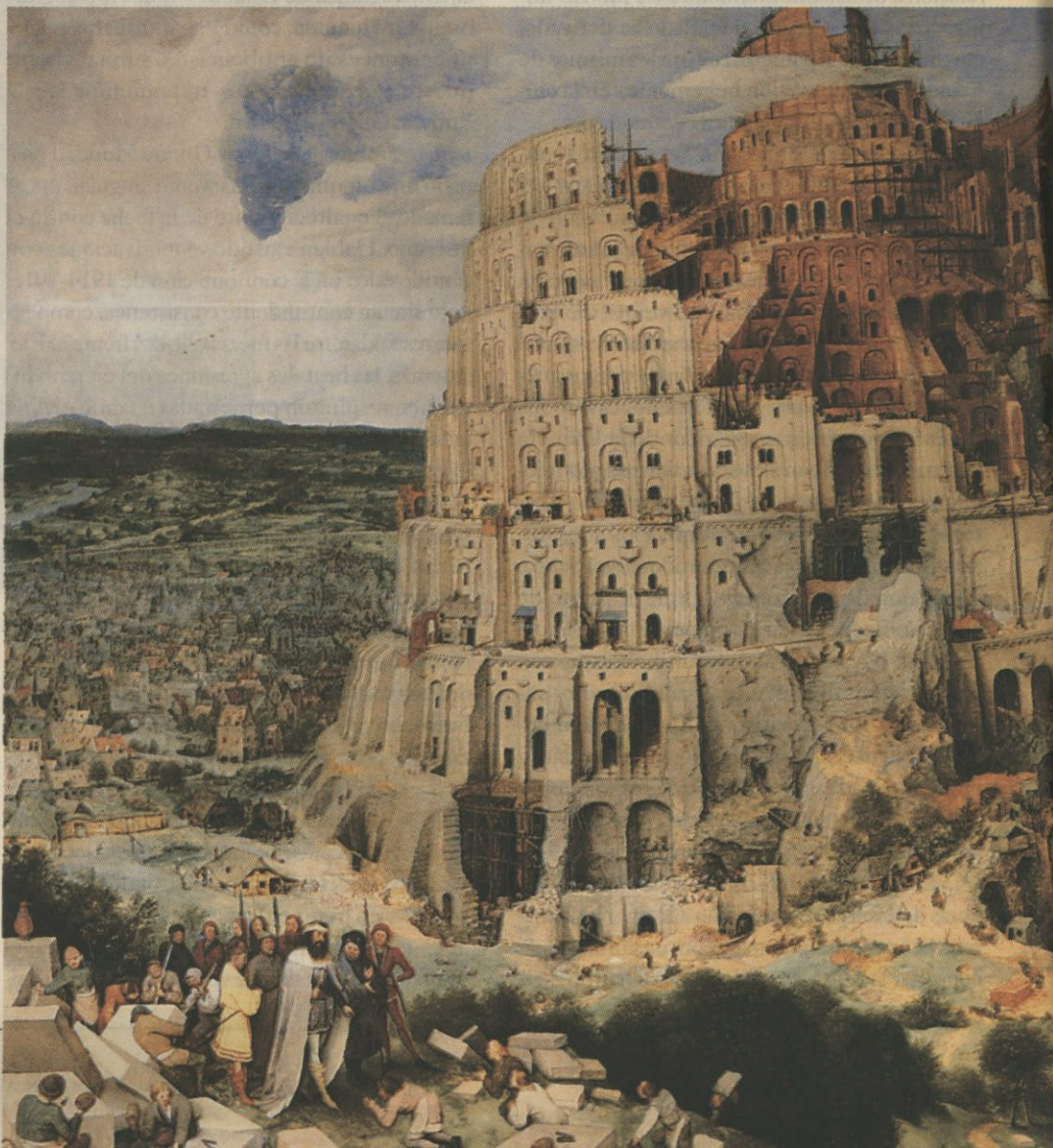
BRUEGHEL: LA CONSTRUCCIÓN DE LA TORRE DE BABEL, 1563
