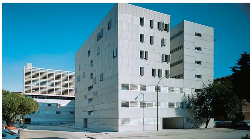
VISTA DE LAS VIVIENDAS DE MATOS-CASTILLO EN MADRID
