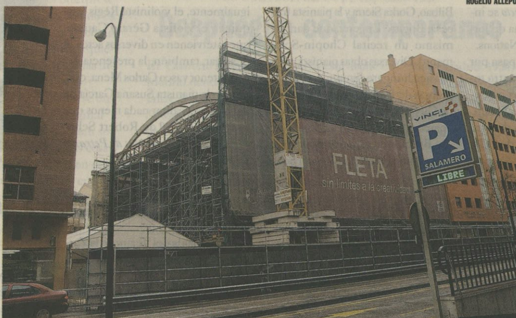
ASPECTO DE LAS OBRAS DE REMODELACIÓN DEL TEATRO FLETA
