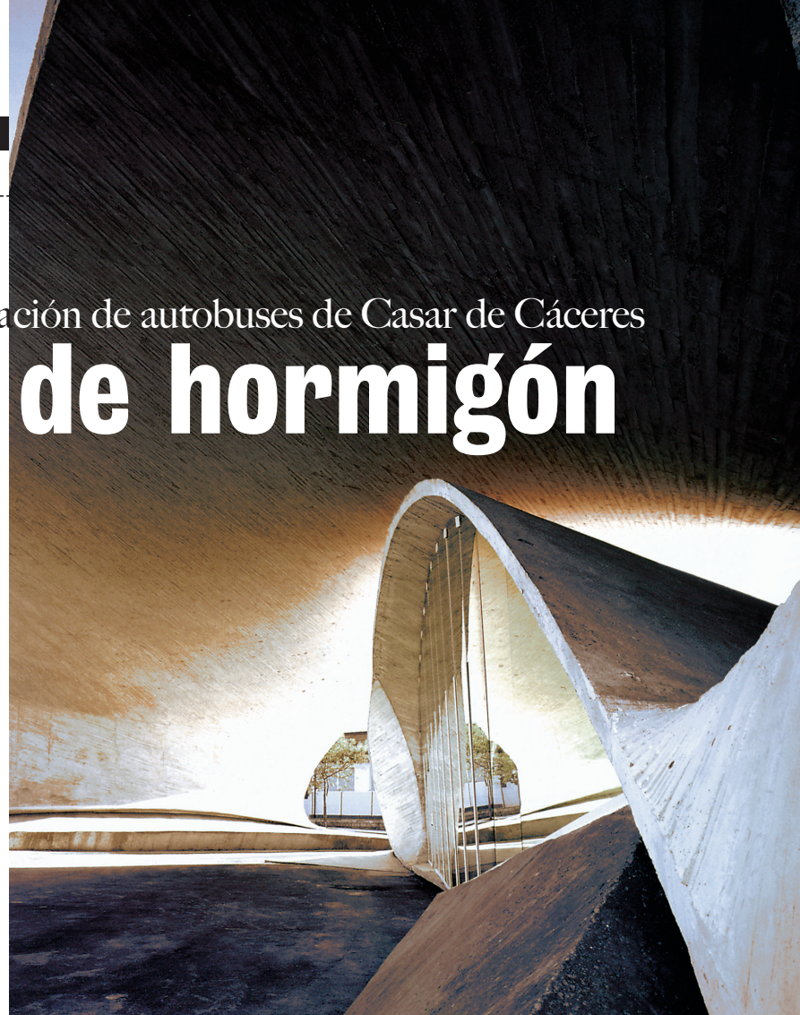
VISTA DE LA ENTRADA DE LA ESTACIÓN DE CASAR (CÁCERES)
