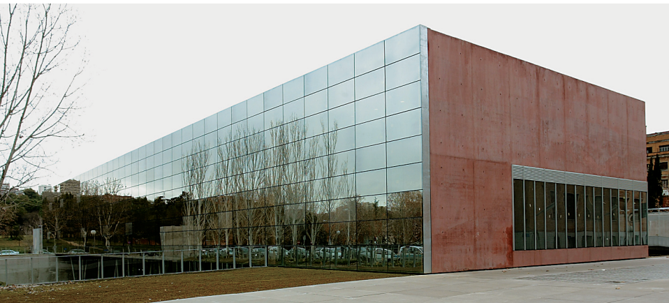
ALBERTO NEVADO. PASAJES DE ARQUITECTURA
