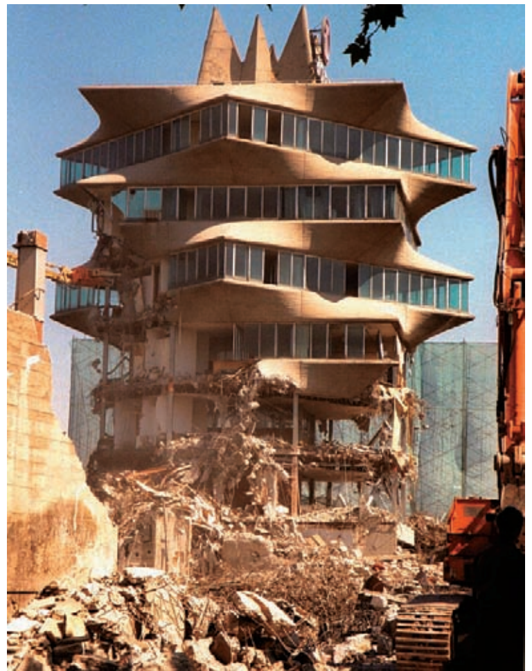
FISAC ASISTIÓ A LA DEMOLICIÓN DE SU PAGODA (MADRID)
