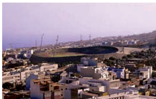
TRES DE LAS OBRAS DE MENIS: DE ARRIBA A ABAJO, IGLESIA DEL SANTÍSIMO REDENTOR (TENERIFE); PARQUE DE CUCHILLITOS DE TRISTÁN Y ESTADIO INSULAR DE ATLETISMO, AMBOS EN TENERIFE
