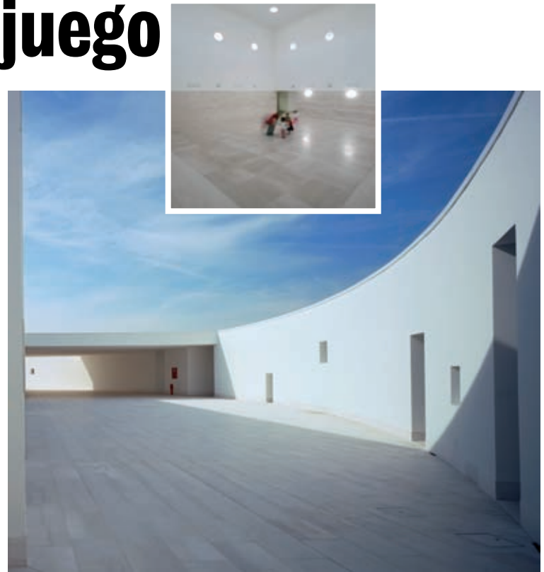
EXTERIOR E INTERIOR DE LA GUARDERÍA BENETTON
