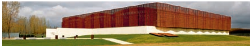
INTERIOR Y EXTERIOR DE LA CUBIERTA
