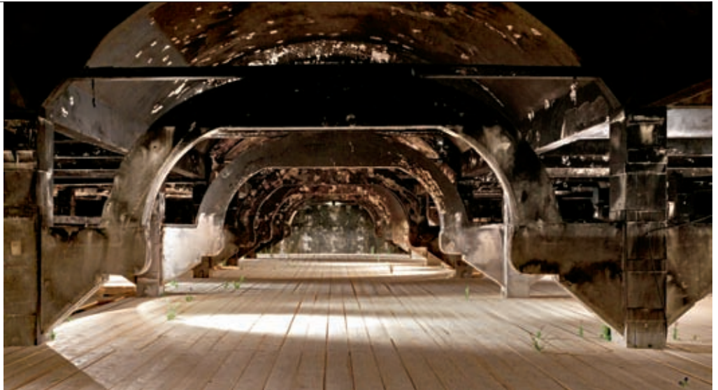
VISTA DE LA INSTALACIÓN CATEGORÍAS EN MATADERO
