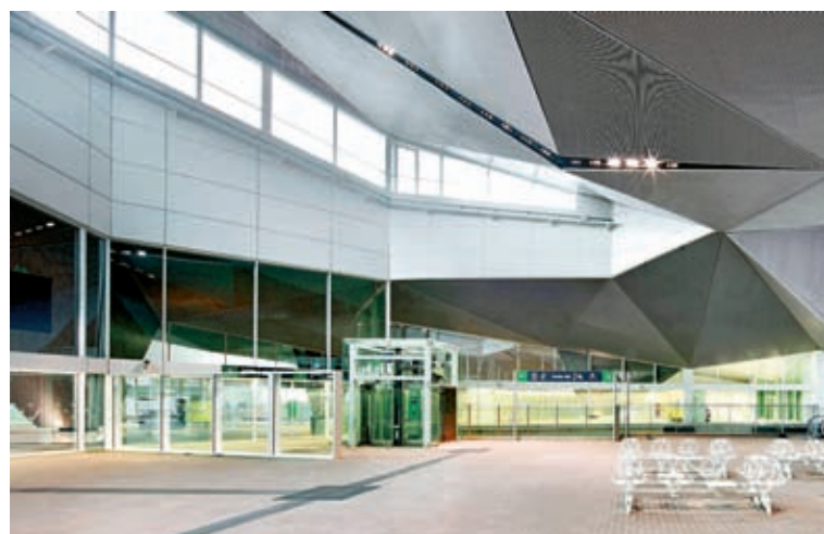
ESPACIO INTERIOR Y PAISAJE DE CUBIERTA DE LA ESTACIÓN INTERMODAL DE LOGROÑO
