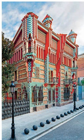
FACHADA DE CASA VICENS. ARRIBA, UNA DE LAS ESTANCIAS INTERIORES
