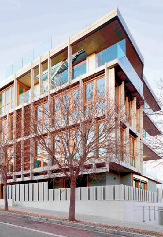
EXTERIOR Y ESCALERAS INTERIORES DEL BLOQUE DE VIVIENDAS
