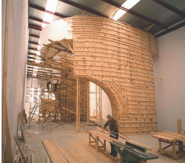
JESÚS URIARTE: CONSTRUCCIÓN DEL ENGOFRADO DE EL ELOGIO DEL HORIZONTE , 1990
