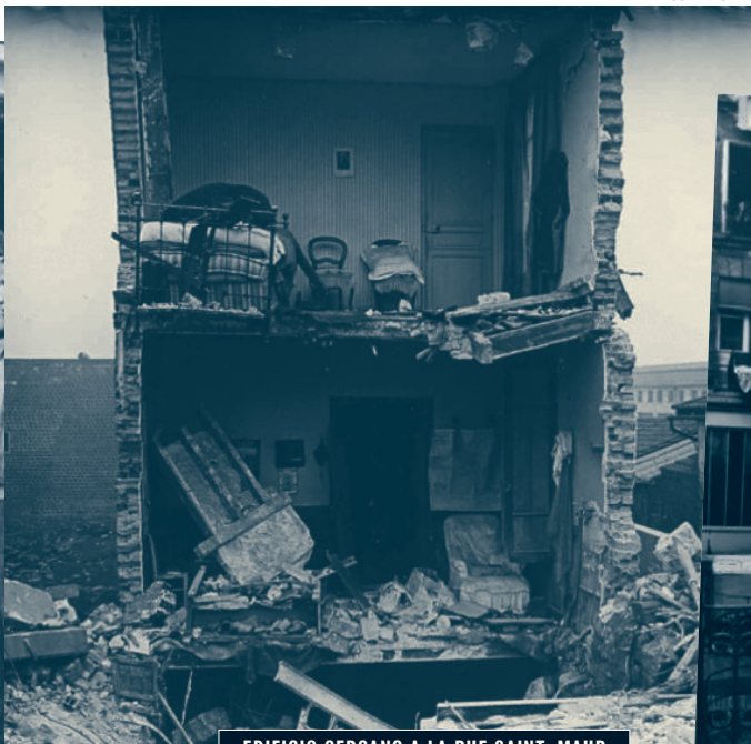
EDIFICIO CERCANO A LA RUE SAINT-MAUR BOMBARDEADO EN LA I GUERRA MUNDIAL
