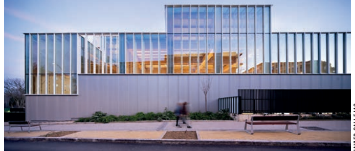
EXTERIOR DE LA BIBLIOTECA DE VILLVERDE. EN LA OTRA PÁGINA, UNA DE LAS SALAS INTERIORES
